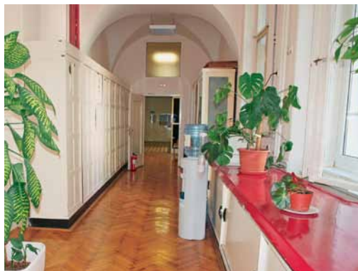
Ulazni hodnik Zavoda prije preuređenja
