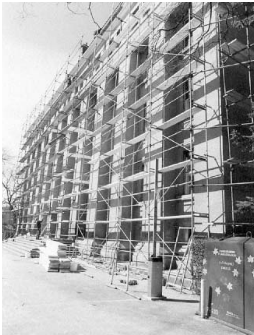
Radovi na obnovi Škole u punom su jeku
